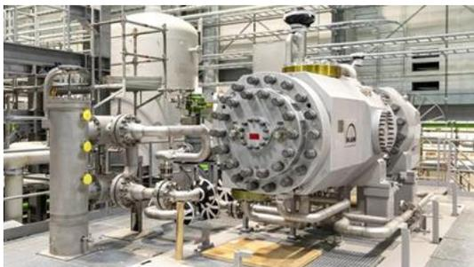
[부록 그림 7] 오스트리아 빈 하수 이용 히트펌프(55 MW)
